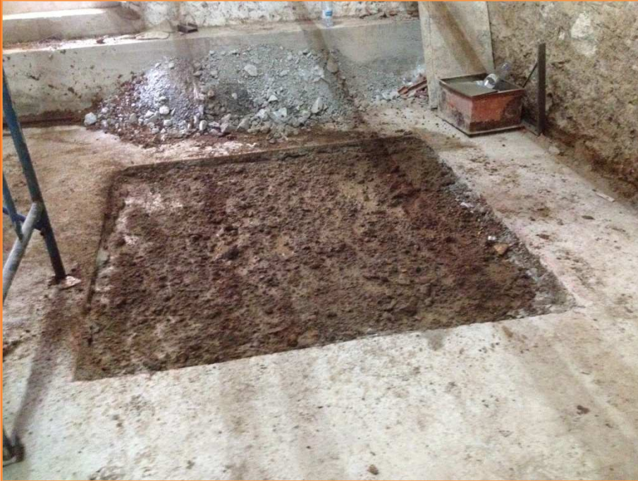
Foto 9. Estat final del sondeig un cop cobert el sondeig realitzat
