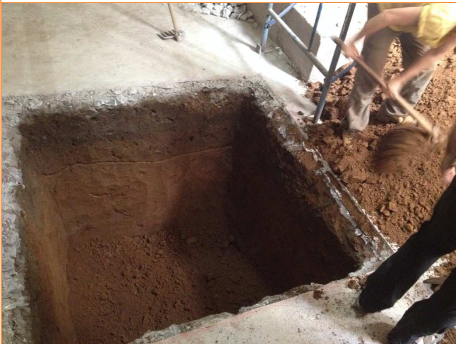
Foto 8. Treballs de cobriment del sondeig.
