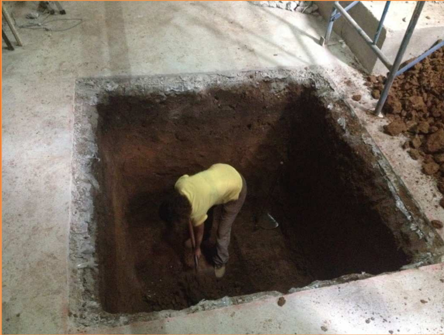
Foto 5. Treballs d'excavació a la part final del sondeig.
